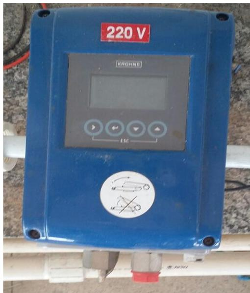
Figura 3. Medidor de vazão eletromagnético.
